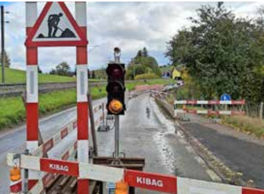
Die verwaiste Baustelle am Huttwiler Orts- eingang – nun wurden die Sanierungsarbeiten endlich aufgenommen. (Bild: M. Fuhrimann)
